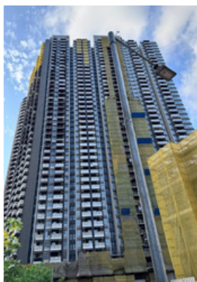
Subsidised sale flats project at Kai Tak Area 2B1, Kowloon 九龍啟德第2B1區資助出售房屋項目
